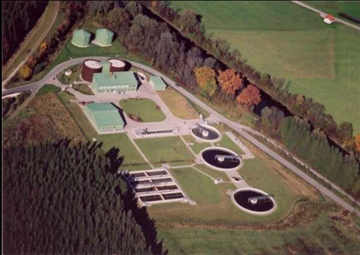
ZV Kläranlage Penzberg-Iffeldorf-Bad Heilbrunn
